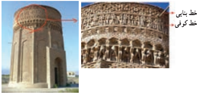
آجر کاری — برج مهماندوست دامغان
